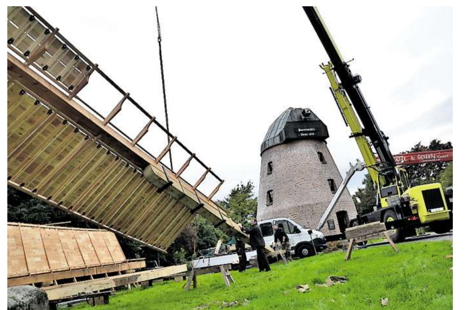
Halt! Stopp! Der Kran ist zu klein, da muss ein größeres Fahrzeug her. Die Zimmerleute passen auf, dass der Flügel unbeschadet abgelegt wird. Foto: A. Hempen
