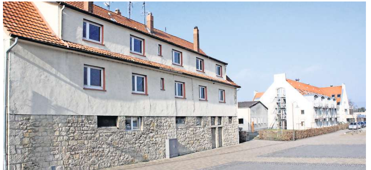
Am Hohen Rott soll das Bürgerzentrum entstehen. Dazu wird das vordere Gebäude abgerissen. FOTO: STEFFEN SCHMIDT
